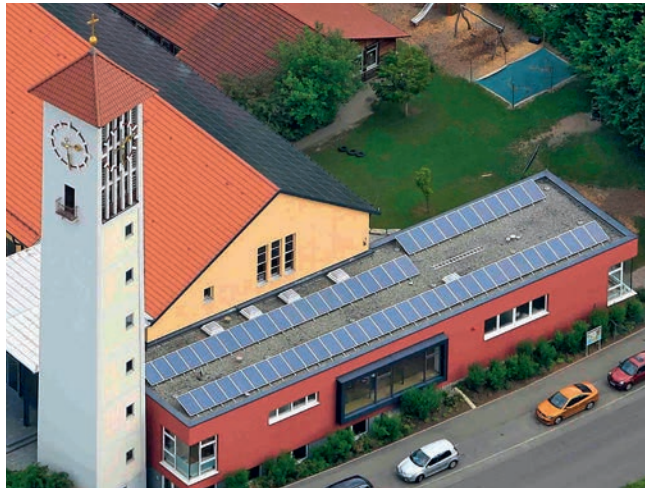
Solardach auf dem Gemeindezentrum Kreuzkirche
