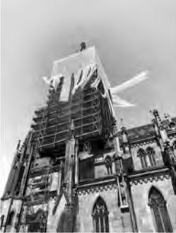
Das Gerüst steht, die Arbeiten am Westturm haben begonnen. Nach der Turmhelmsanierung vor etwa 10 Jahren ist nun der untere Teil des Turmes bis zur Höhe des unteren Umgangs an der Reihe: Fialen, Kreuzblumen
